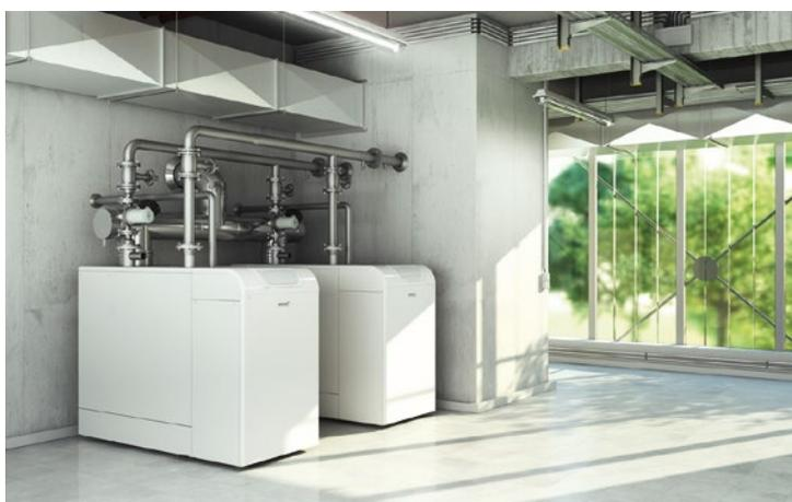
Esta mayor cantidad de calor se obtiene gracias a la reducción progresiva de la temperatura de los humos hasta provocar la condensación del vapor de agua contenido en ellos.
