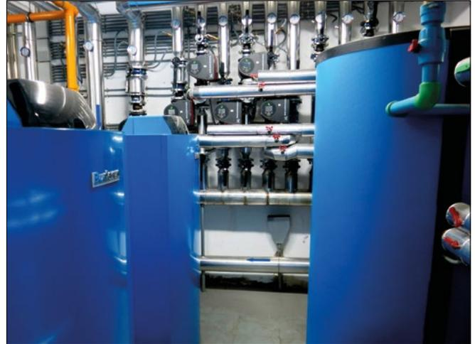
Aislamiento del circuito hidráulico para evitar pérdidas innecesarias en sala de calderas.
