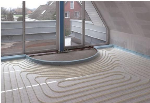
Por este motivo el sistema de suelo radiante permite alcanzar el máximo confort térmico en cualquier tipo de edificio, trabajando en los valores óptimos de temperatura operativa según UNE-EN ISO 7730 y obteniendo el máximo rendimiento de los equipos térmicos, lo que posibilita ahorros sustanciales por la reducción del consumo energía y en emisiones de CO<sub>2</sub>.
