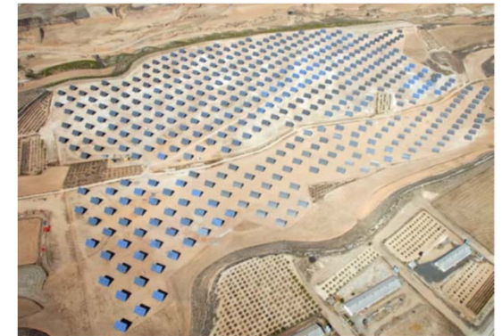
Imagen aérea, planta fotovoltaica 5 MW
