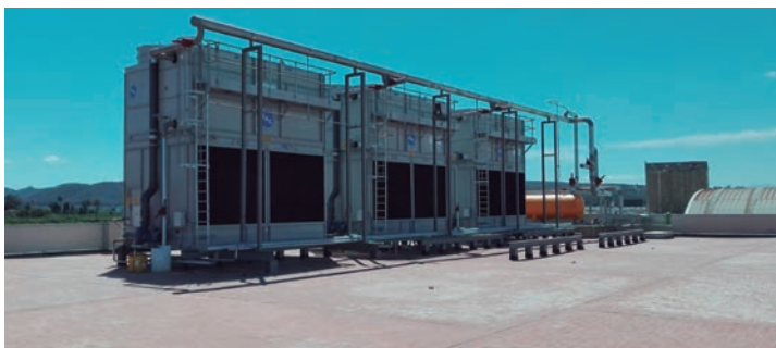
Vista de los nuevos condensadores evaporativos.
